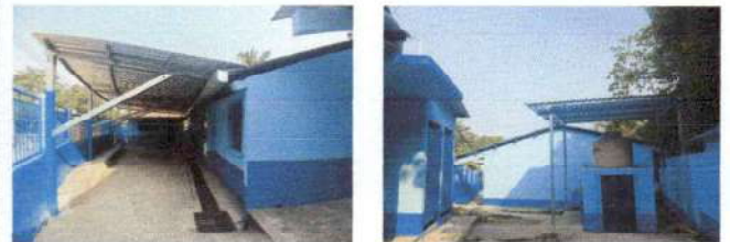
Foto 2: Fotos de los techados finalizado.
