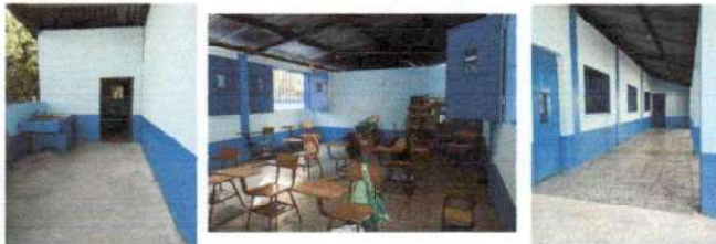
Foto 3: Fotos de los paredes interiores y exteriores pintado.
