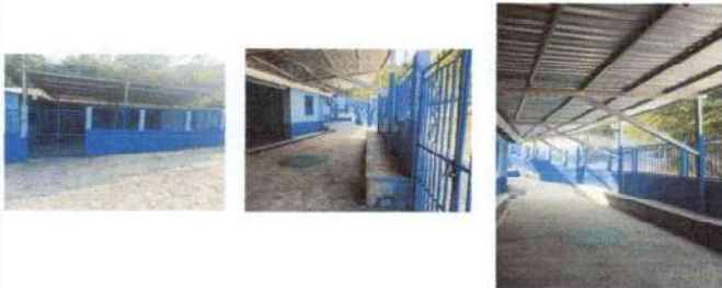
Foto1: Fotos del techado finalizado.
