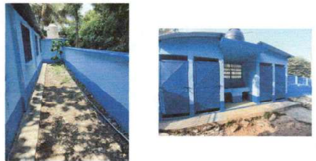
Foto 4: Fotos de los paredes interiores y exteriores pintado.
