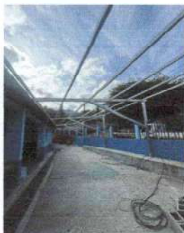
Foto1: Fotos del proceso de elaboración del techado.
