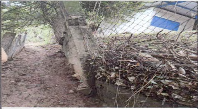
Sustitucion de 70 Metros de muro perimetral de block
