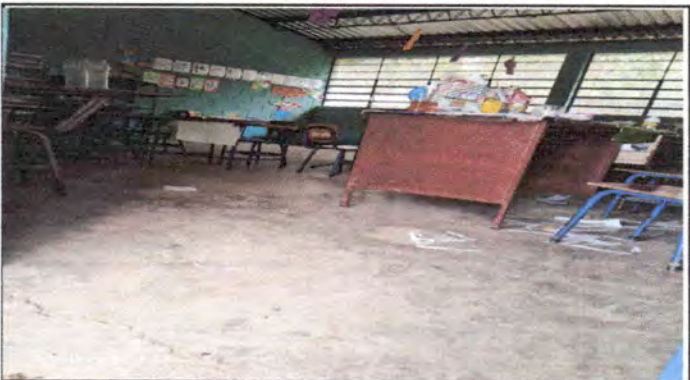
Sustitucion de 50 metros de piso de cemento por piso ceramico
