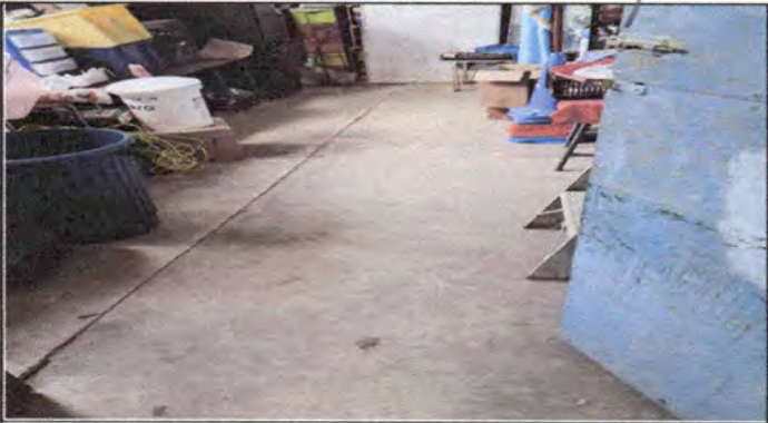
Sustitucion de 22 metros de piso de cemento por piso ceramico
