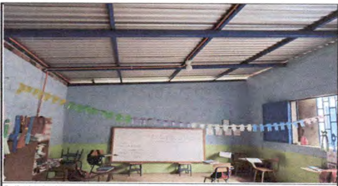
Sellado de 14 metros lineales de grietas y fisuras en muros
