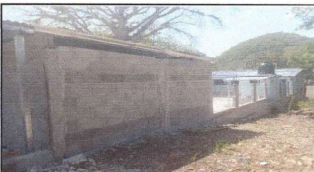
Foto 4: Terminado el muro perimetral con blok y malla de la parte de atrás.
