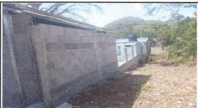
Foto 3: Terminado el muro perimetral con blok y malla de la parte de atrás.
