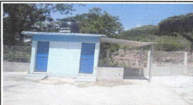
Foto 1: Terminado el muro perimetral con blok y malla de la parte de atrás y arreglos de los baños.
