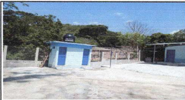
Foto 2: Terminado el muro perimetral con blok y malla de la parte de atrás y arreglos de los baños.
