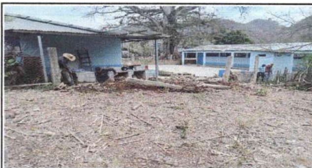
Foto 3: En proceso de Reparacion de muro perimetral con blok y malla de la parte de atras.
