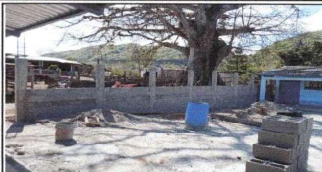
Foto 2: En proceso de Reparacion de muro perimetral con blok y malla de la parte de atras.
