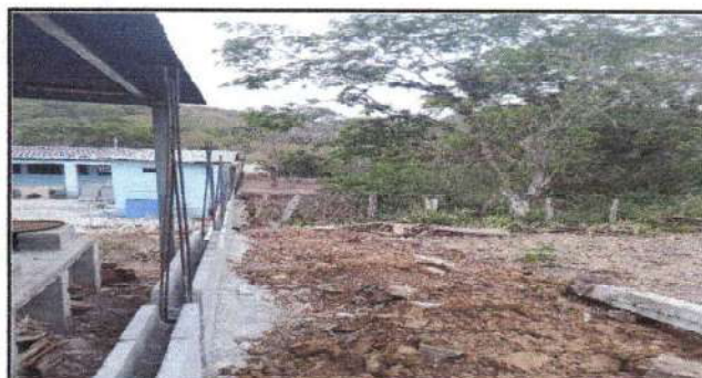
Foto 4: En proceso de Reparacion de muro perimetral con blok y malla de la parte de atras.
