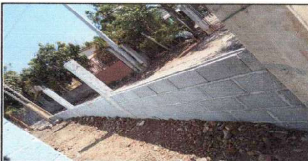
Foto 6: En proceso dereparacion de muro perimetral con block y malla de la parte
