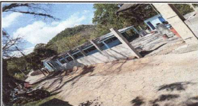
Foto 1: En proceso de muro perimetral con blok y malla de la parte de atras.
