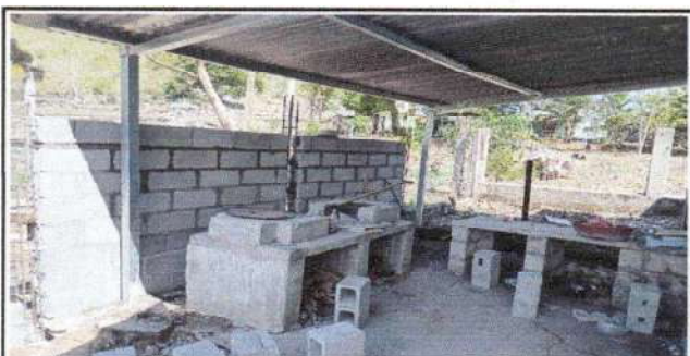
Foto 5: En proceso de Reparación de cocina
