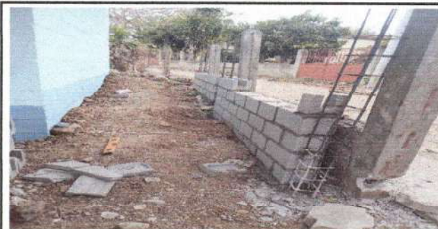
Foto 3: En proceso de Reparacion de muro perimetral con blok y malla de la parte de atras.
