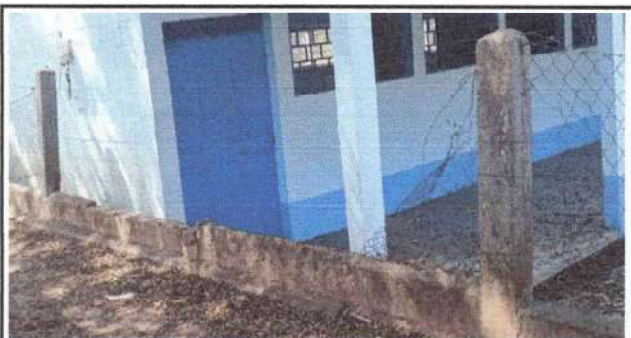
Foto 3: Reparacion de muro perimetral con blok y malla de la parte de enfrente.
