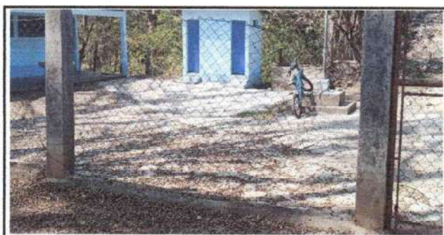
Foto 6: Reparacion de muro perimetral con blok y malla de la parte de enfrente.
