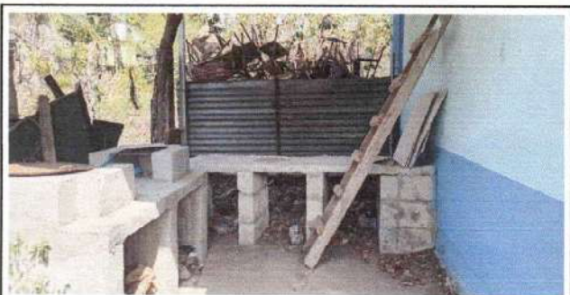
Foto 5: Reparación de cocina
