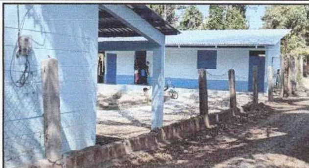
Foto 2: Reparacion de muro perimetral con blok y malla de la parte de enfrente.
