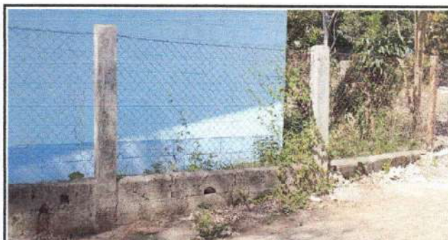
Foto 4: Reparacion de muro perimetral con blok y malla de la parte de enfrente.
