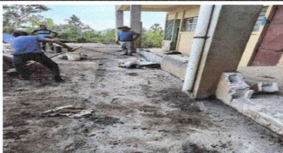
REPARACION DE 54 METROS DE PAVIMENTO
