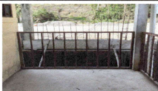
INSTALACION DE BARANDA METALICA
