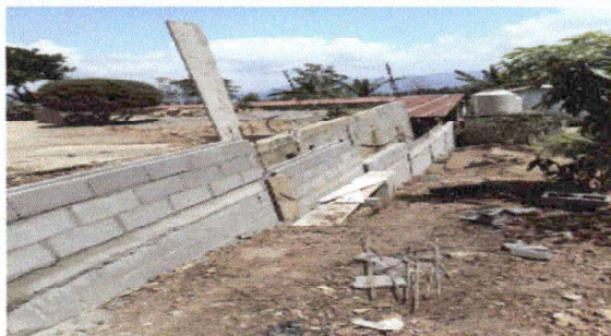
SUSTITUCION DE 54 METROS DE CERCO POR TAPIAL CON MALLA
