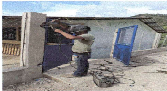
REPARACION LIJADO Y PINTURA DE PORTON
