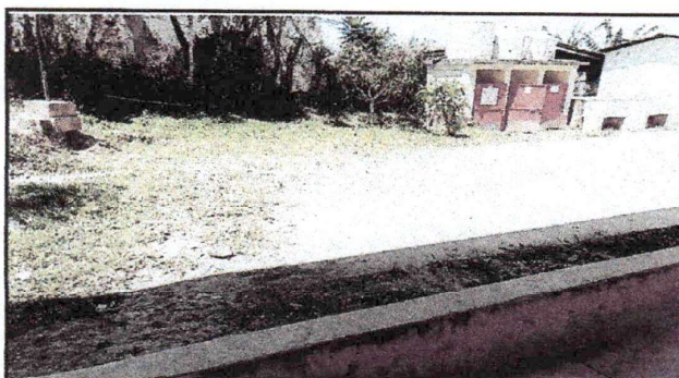
REPARACION DE 54 METROS DE PAVIMENTO
