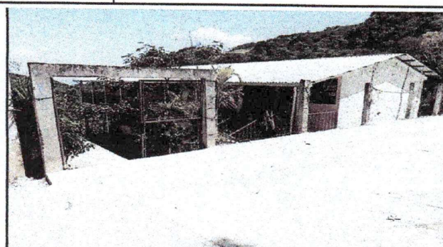
REPARACION LIJADO Y PINTURA DE PORTON
