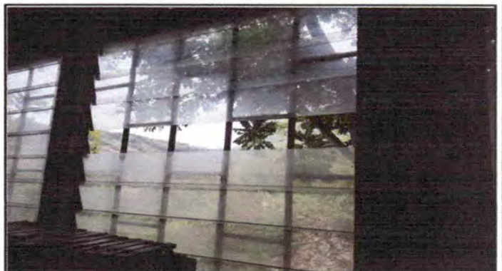
Sustitucion de 18 vidrios en ventanas
