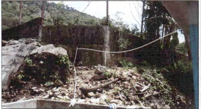
Limpieza y ampliacion de 5 metros cuadrados de fosa septica
