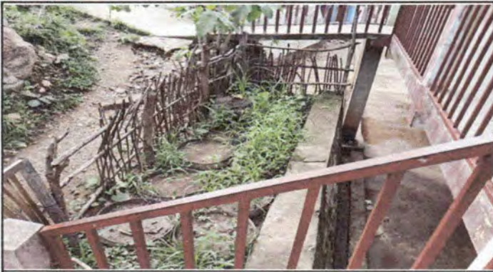
continuación de 14 metros cuadrados de muro de contencion
