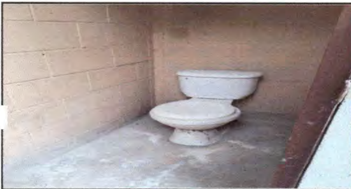
Sustitucion de 3 inodoros
