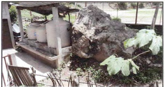
Demolicion de piedra
