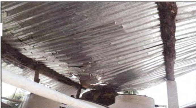
Sustitucion de estructura y 100 metros cuadrados de lamina por lamina troquelada c,26
