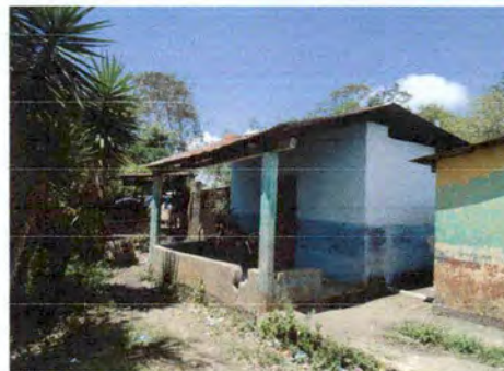
sustitucion de techo
