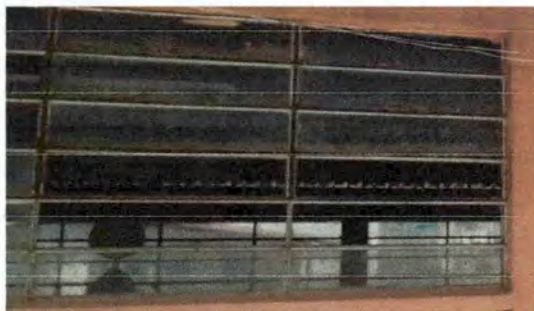
SUSTITUCION DE VIDRIOS
