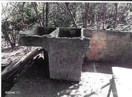
Foto 5: Sustitucion de pila de concreto
