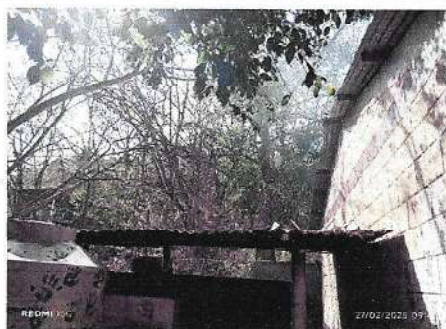
Foto 2: Cambio de lamina en cocina
