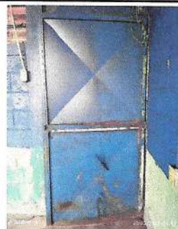
Foto 6: Mantenimiento de puertas
