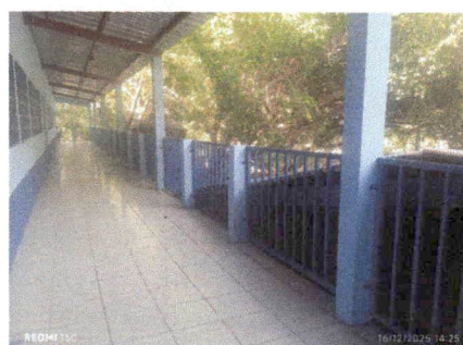
Foto 4: Mantenimiento a barandas de metal
