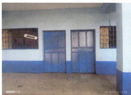
Foto 1: Mantenimiento a estructura de puertas (lijado, cambio de tubo, cepillado, sujeciones, aplicación de pintura)
