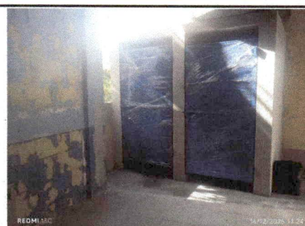
Foto 6: Continuación de muro de block en baños
