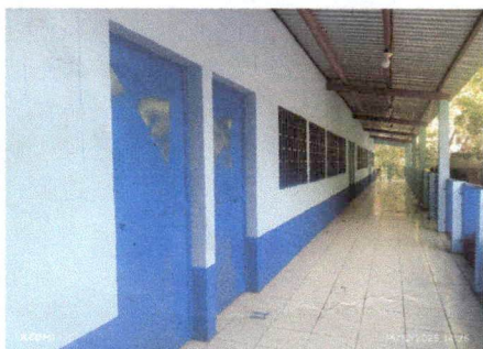
Foto 3: Mantenimiento a balcones de metal
