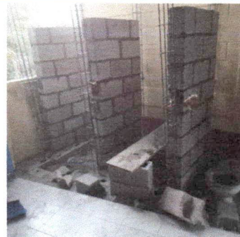
Foto 6: Continuacion de muro de block en baños
