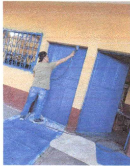
Foto1: Mantenimiento a estructura de puertas (lijado, cambio de tubo , cepillado, sujeciones, aplicación de pintura)
