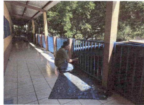
Foto 4: Mantenimiento a barandas de metal
