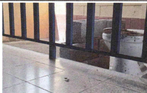
Foto 6: Continuación de muro de block en baños
