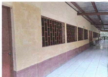
Foto 3: Mantenimiento a balcones de metal
