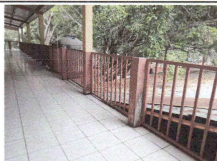
Foto 4: Mantenimiento a barandas de metal
