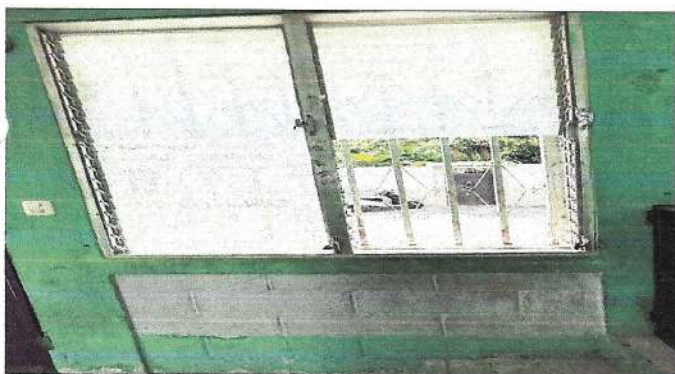
SUSTITUCIÓN DE VENTANAS POR PVC
