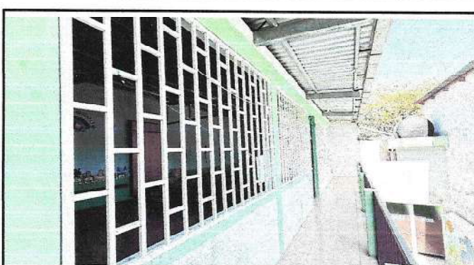
INSTALACION DE MALLA DESPLEGABLE Y PINTURA DE BALCONES
