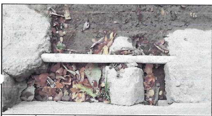
SUSTITUCIÓN DE TUBERÍA DE DRENAJE
