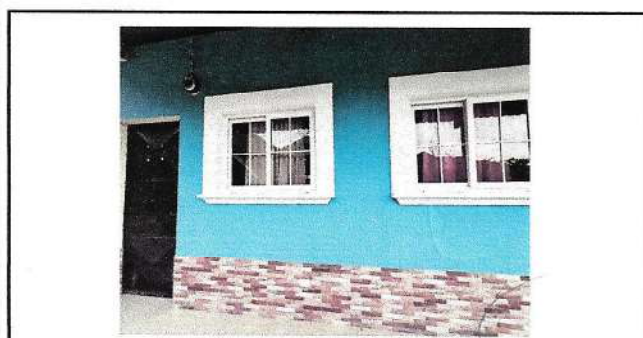
Foto 5: Balcón de Seguridad y Ventana
