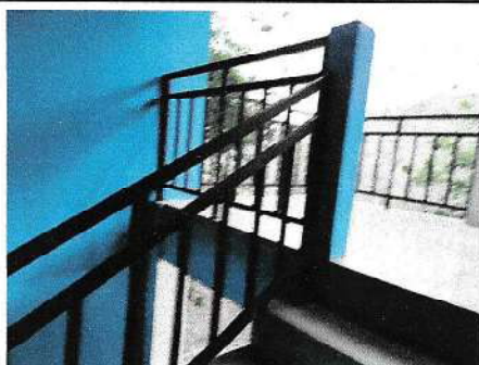
Foto 19: Remozamiento de baranda
