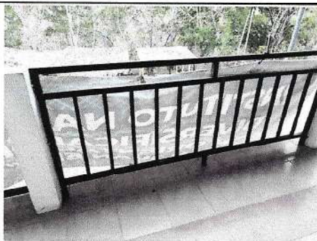
Foto 15: Remozamiento de baranda
