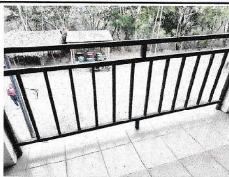
Foto 14: Remozamiento de baranda
