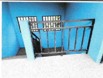
Foto 18: Remozamiento de baranda
