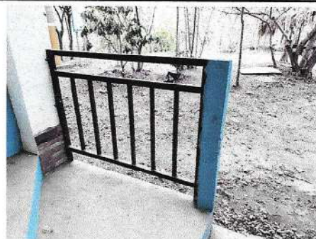
Foto 22: Remozamiento de baranda
