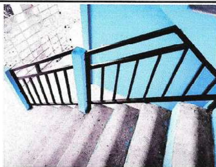
Foto 20: Remozamiento de baranda
