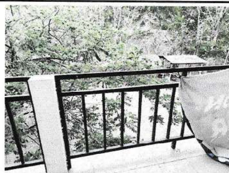
Foto 16: Remozamiento de baranda
