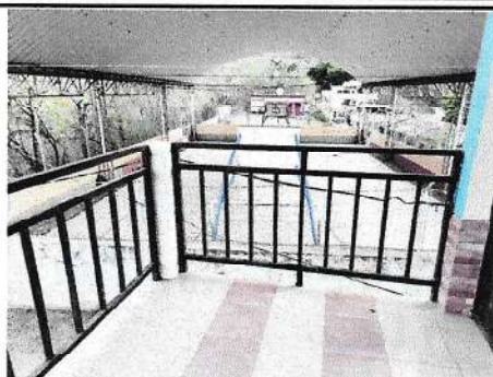
Foto 13: Remozamiento de baranda
