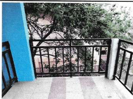
Foto 17: Remozamiento de baranda
