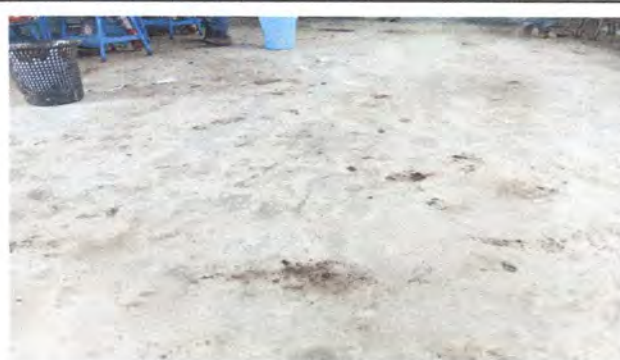
Foto 4: Sustitución de piso cerámico.
