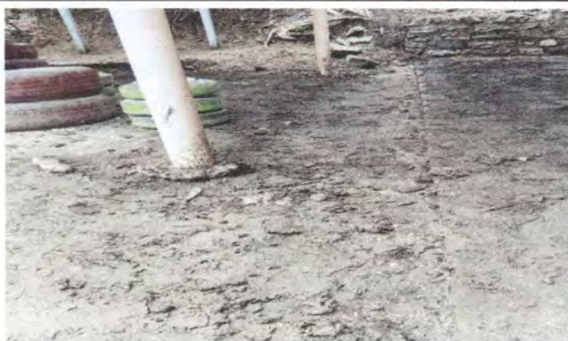
Foto 3: Reparación de piso de torta de concreto 25 MTS cuarteados
