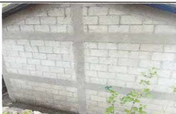
Foto 6: Pintura en muros exteriores
