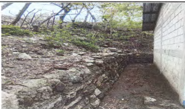
Foto 5: Sustitución de cuneta de concreto de agua pluvial 12 metros lineales
