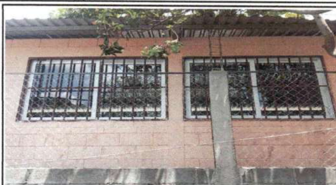
Foto 2: fabricación e instalación de ventanas pvc de 1.28 x 1.96
