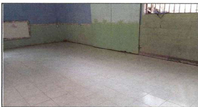
Foto 5: Instalación de piso cerámico
