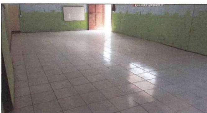
Foto 6: Instalación de piso cerámico
