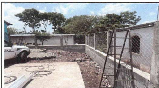
Foto 3: Reparación de Muro perimetral 40ml
