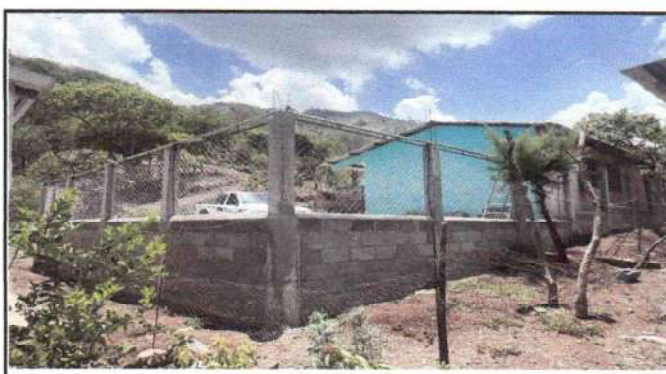
Foto 4: Reparación muro perimetral 40ml
