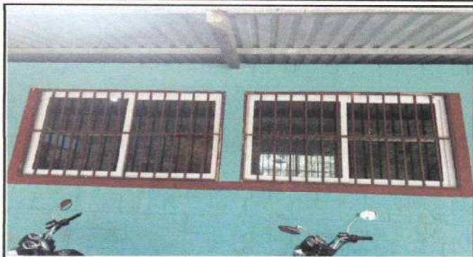
Foto1: fabricación e instalación de ventanas pvc de 1.28 x 1.96
