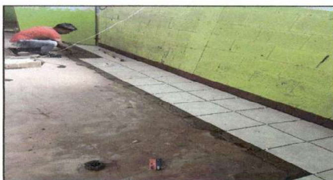
Foto 5: Instalación de piso cerámico
