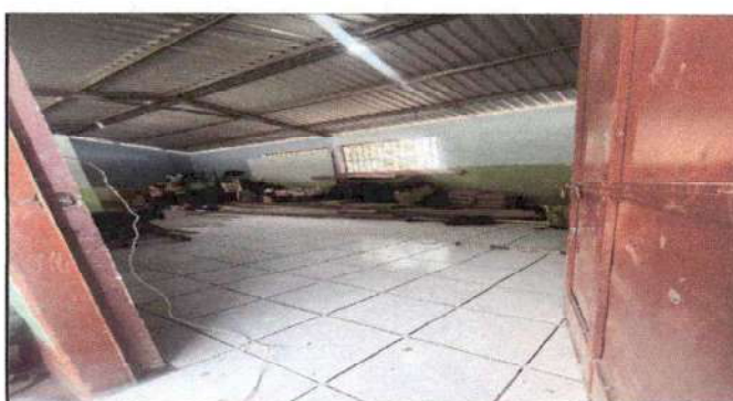
Foto 6: Instalación de piso cerámico
