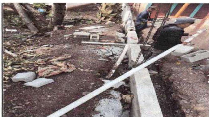
Foto 3: Reparación de Muro perimetral 40ml
