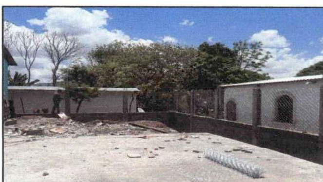
Foto 4: Reparación muro perimetral 40ml
