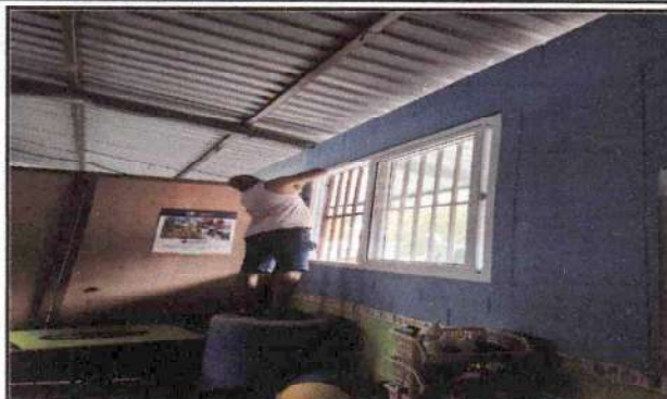
Foto1: fabricación e instalación de ventanas pvc de 1.28 x 1.96
