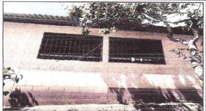
Fabricación e instalación de ventanas pvc de 1.28 x 1.96
