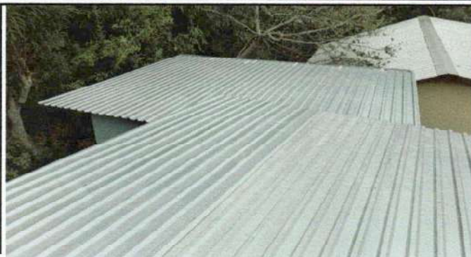
Foto1: Sustitución de lámina troquelada
