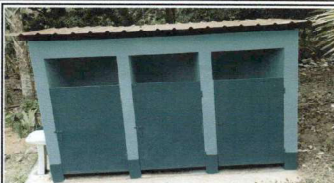
Foto 2: Mantenimiento puertas de metal
