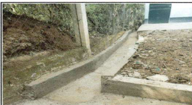
Foto 4: Reparación de cuneta de concreto
