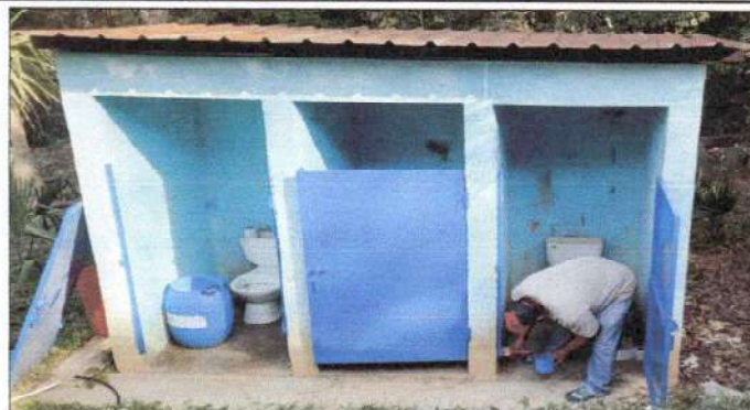
Foto 2: Mantenimiento puertas de metal
