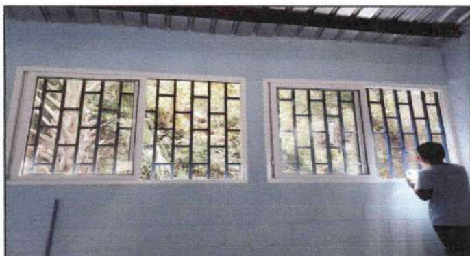
Foto 3: Mantenimiento a estructura de metal de ventana
