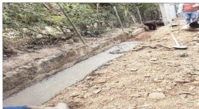
Foto 4: Reparación de cuneta de concreto
