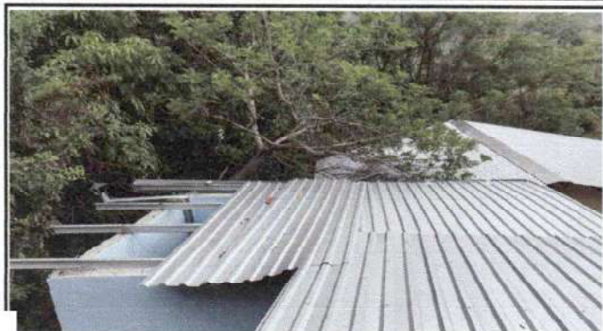
Foto 1: Sustitución de lámina troquelada
