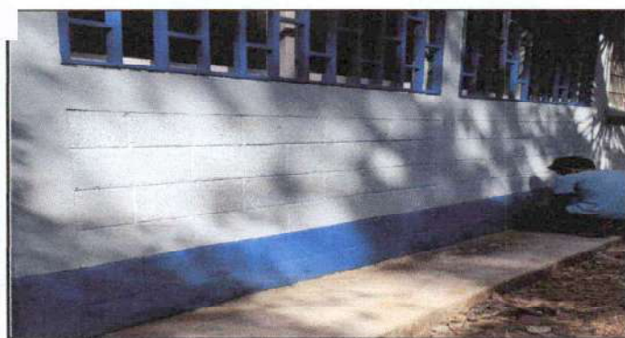
Foto 5: Pintura en muros exteriores e interiores
