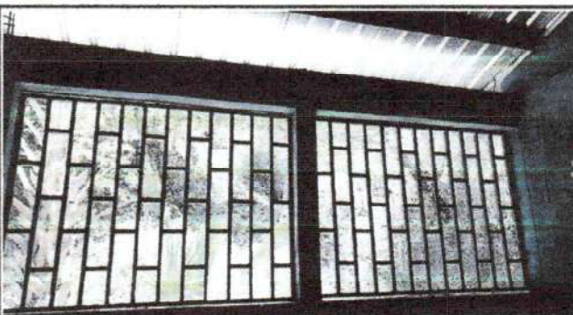
Foto 3: Mantenimiento a estructura de metal de ventana
