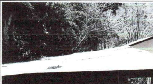
Foto 1: Sustitución de lámina troquelada
