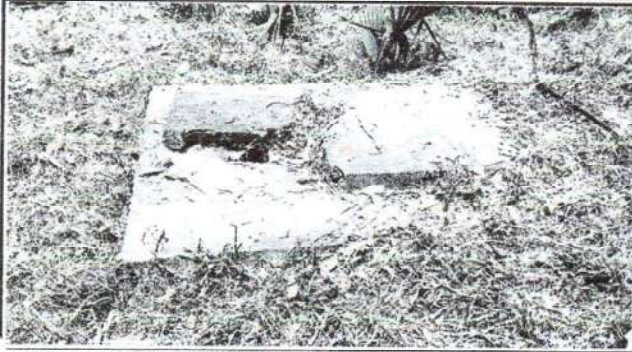
Foto 1: Limpieza de fosa séptica y reparación de tapadera de caja
