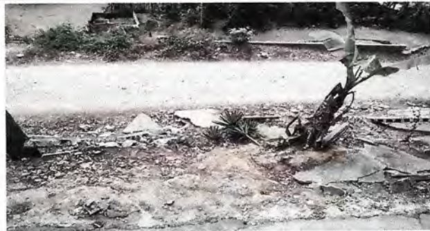
Foto 5: Reparación de planchas de concreto de patio
