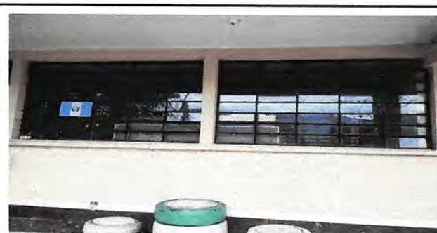
Foto 6: Fabricación e instalación de balcones de hierro en ventana.
