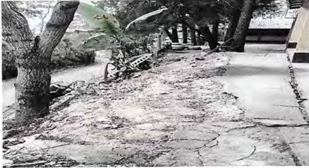
Foto 1: Reparación de planchas de concreto de patio
