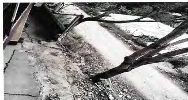
Foto 6: Reparación de planchas de concreto de patio
