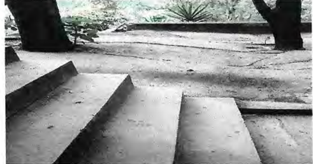
Foto 4: Reparación de planchas de concreto de patio
