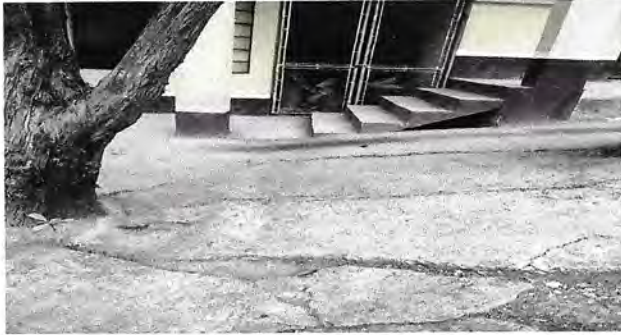
Foto 3: Reparación de planchas de concreto de patio
