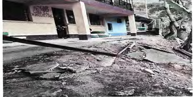
Foto 2: Reparación de planchas de concreto de patio
