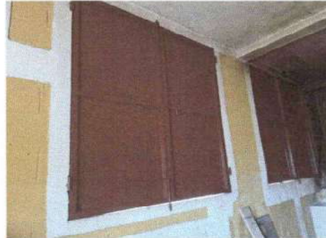
Foto 4: Mantenimientos de ventanas
