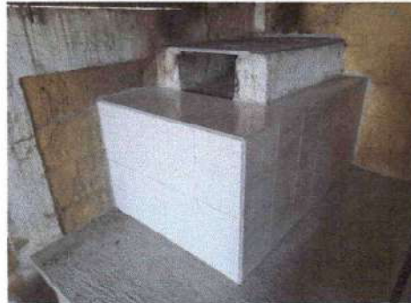
Foto 2: Instalación de azulejo en estufa rural
