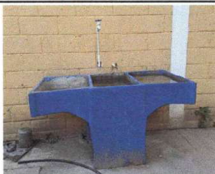
Foto 5: Sustrucción de pila de concreto en baños
