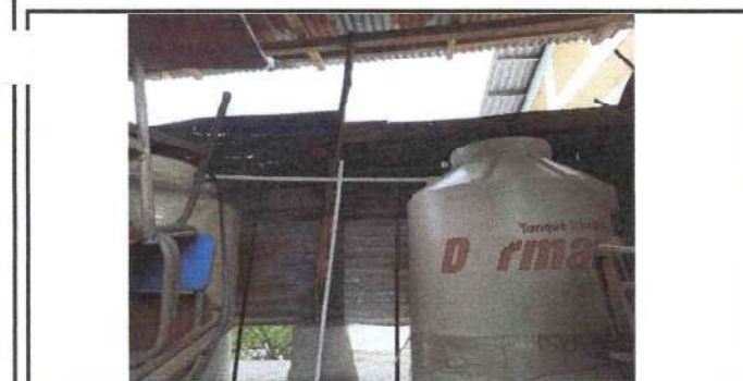
Foto 5: Sustrucción de depósito de agua 1100 lt en baños
