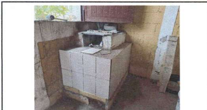
Foto 2: Instalación de azulejo en estufa rural
