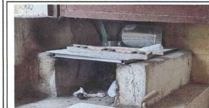
Foto1: Sustrucción de estufa completa incluye chimenea y plancha de metal
