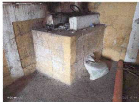
Foto 2: Instalación de azulejo en estufa rural
