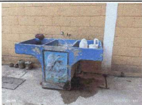
Foto 5: Sustrucción de pila de concreto en baños
