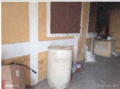
Foto 4: Mantenimientos de ventanas
