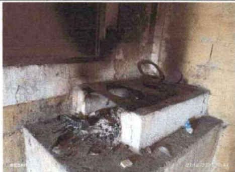
Foto 1: Sustrucción de estufa completa incluye chimenea y plancha de metal
