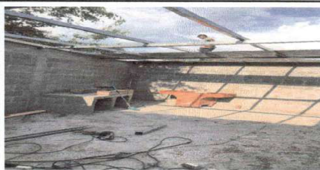
MANTENIMIENTO Y REPARACIÓN DE COCINA DE 10 METROS CUADRADOS
