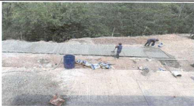
REPARACIÓN DE 90 METROS CUADRADOS DE PAVIMENTO
