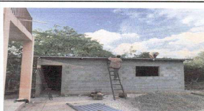
MANTENIMIENTO Y REPARACION DE COCINA DE 16 METROS CUADRADOS
