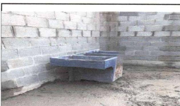
MANTENIMIENTO Y REPARACIÓN DE COCINA DE 10 METROS CUADRADOS
