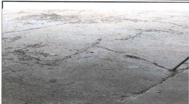
REPARACIÓN DE 90 METROS CUADRADOS DE PAVIMENTO
