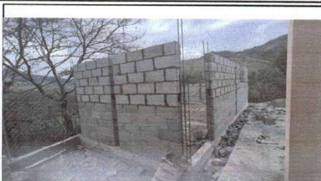
MANTENIMIENTO Y REPARACION DE COCINA DE 16 METROS CUADRADOS
