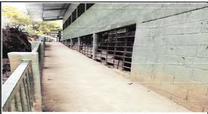
Sustitucion de ventanas de vidrio por ventanas corredizas de metal 2.29 x 1.57
