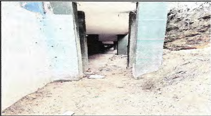
reparaion de cuneta de concreto
