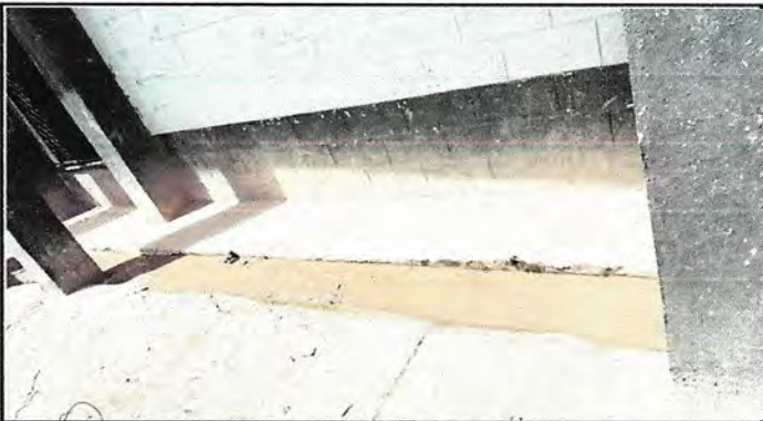
Instalaion de 3 metros de rejia de metal en cuneta
