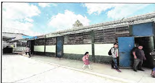
PINTURA MUROS DE INTERIORES Y EXTERIORES
