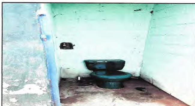
SUSTITUCION DE ACCESORIOS EN SANITARIOS
