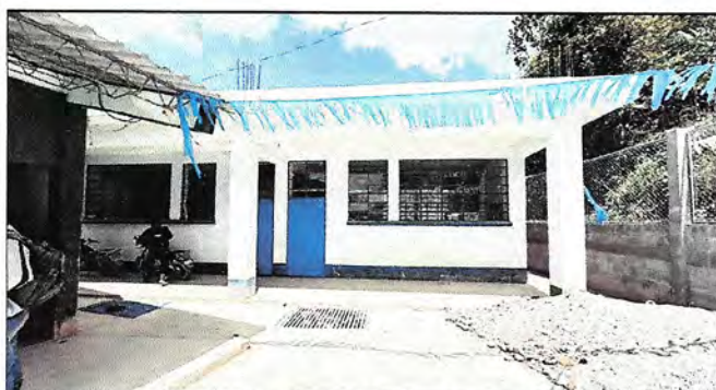
MANTENIMIENTO DE ESTRUCTURA LIJADO Y APLICACIÓN DE PINTURA
