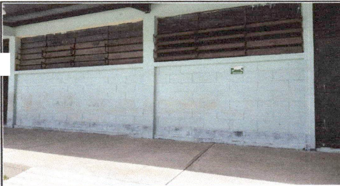
Pintura en muros exteriores e interiores
