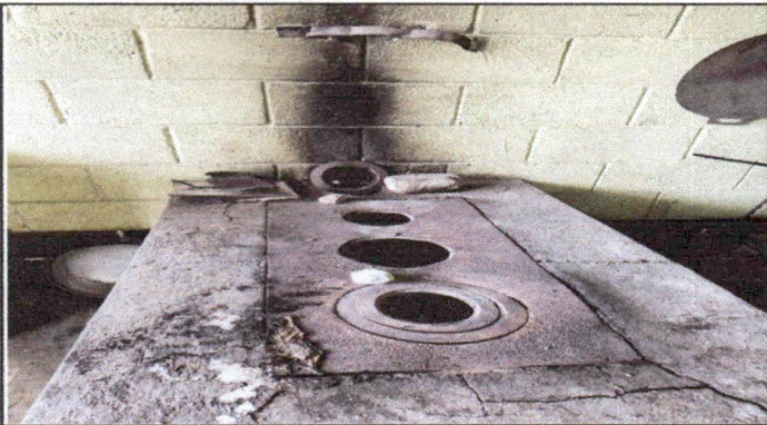
Sustitucion de estufa rural completa
