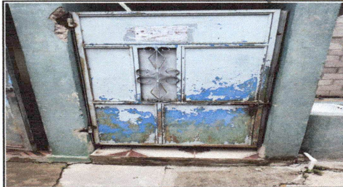
Mantenimiento de estructura ( lijado, cambio de tubo, cepillado y plicacion de pintura)
