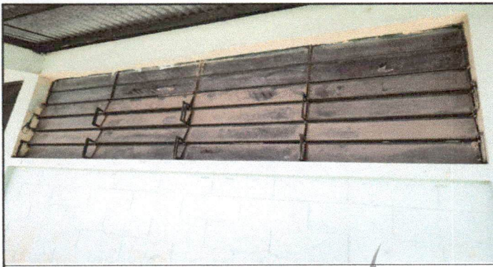
Sustitucion de ventanas de vidrio por ventanas pvc
