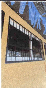
Foto 7: Fabricación e instalación de ventana PBC blanco y balcón de metal, medidas 2.36 x 1.15.
