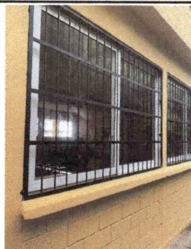
Foto 6: Fabricación e instalación de ventana PBC blanco y balcón de metal, medidas 2.16 x 1.65.
