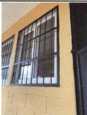
Foto 3: Fabricación e instalación de ventana PBC blanco y balcón de metal, medidas 1.13 x 1.26.
