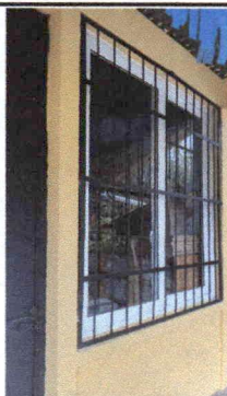
Foto 9: Fabricación e instalación de ventana PBC blanco y balcón de metal, medidas 1.60 x 2.00.
