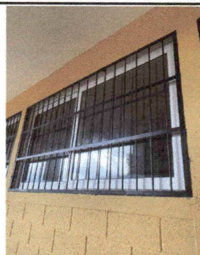
Foto 2: Fabricación e instalación de ventana PBC blanco y balcón de metal, medidas 2.31 x 1.26.
