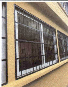
Foto 5: Fabricación e instalación de ventana PBC blanco y balcón de metal, medidas 2.32 x 1.67.
