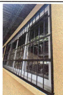
Foto 10: Fabricación e instalación de ventana PBC blanco y balcón de metal, medidas 3.47 x 1.58.
