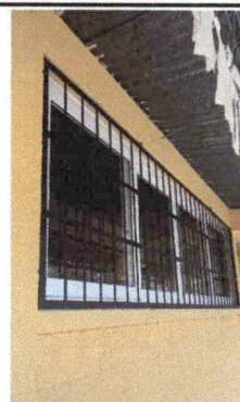
Foto 8: Fabricación e instalación de ventana PBC blanco y balcón de metal, medidas 3.47 x 1.15.
