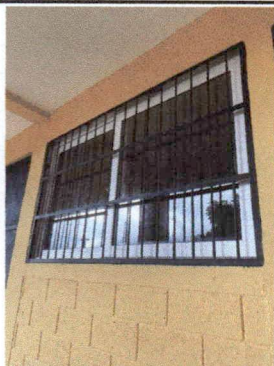
Foto 1: Fabricación e instalación de ventana PBC blanco y balcón de metal, medidas 2.17 x 1.26.
