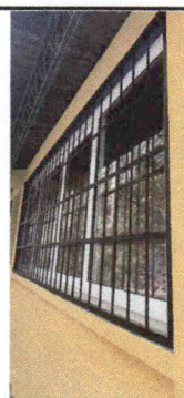
Foto 11: Fabricación e instalación de ventana PBC blanco y balcón de metal, medidas 3.47 x 1.55.
