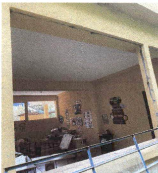
Foto 5: Fabricación e instalación de ventana PBC blanco y balcón de metal, medidas 2.32 x 1.67.
