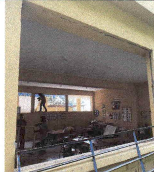
Foto 6: Fabricación e instalación de ventana PBC blanco y balcón de metal, medidas 2.16 x 1.65.
