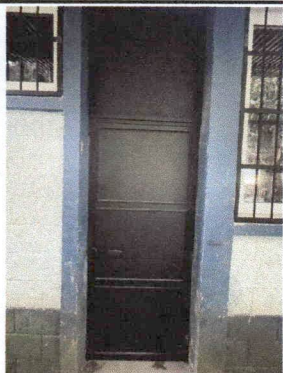
Foto 13: Fabricación e instalación de puerta de metal, medidas 0.90 x 2.90.
