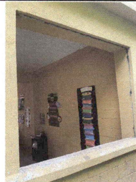
Foto 4: Fabricación e instalación de ventana PBC blanco y balcón de metal, medidas 2.32 x 1.67.
