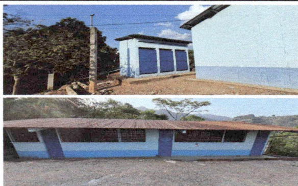
mantenimiento a estructura de puertas de metal (lijado, cepillado y aplicación de pintura)
