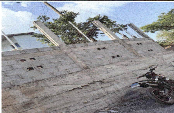
Sustitucion de muro por muro perimetral de cemento con piedra block de 20, tubo hg malla galvanizada soleras intermedias y columnas de hierro
