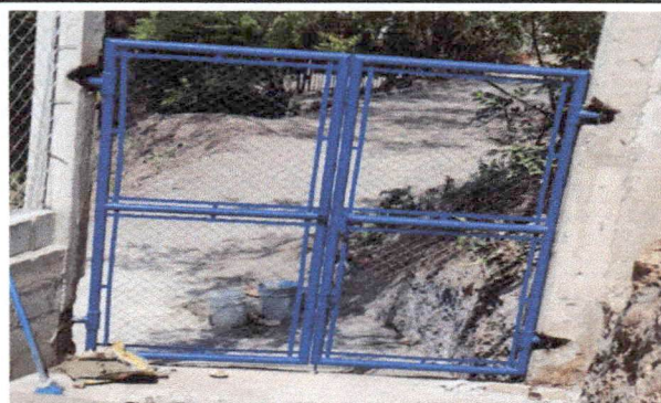
sustitucion de puerta de metal por porton de malla
