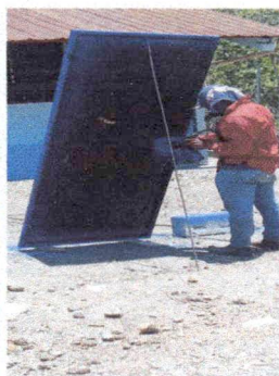
mantenimiento a estructura de puertas de metal (lijado, cepillado y aplicacion de pintura)
