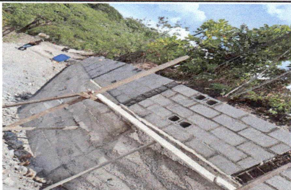
Sustitucion de muro por muro perimetral de cemento con piedra block de 20, tubo hg malla galvanizada soleras itermedias y columnas de hierro
