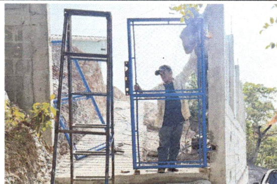
sustitucion de puerta de metal por porton de malla
