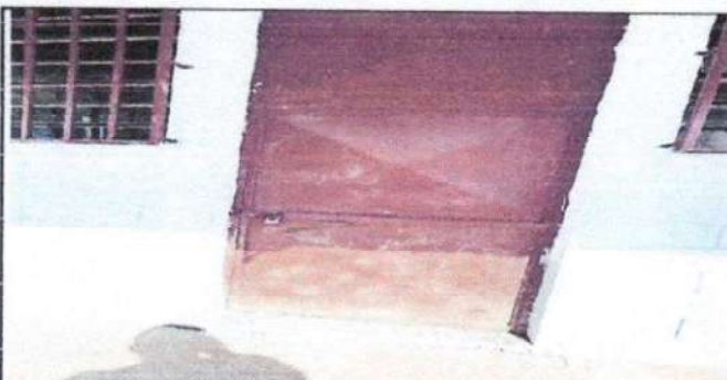
mantenimiento a estructura de puertas de metal (lijado, cepillado y aplicación de pintura)
