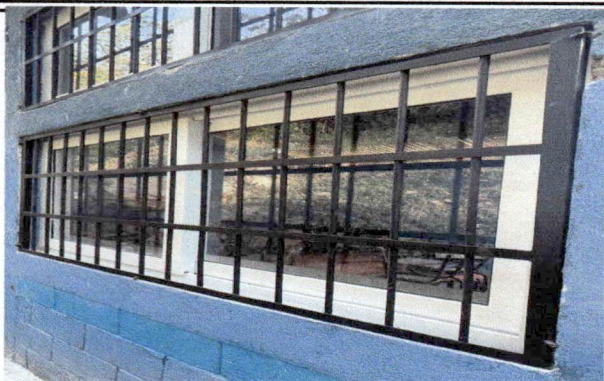
Foto 1: Ventana de pvc y balcón de metal de 1.80 x 0.90mts.
