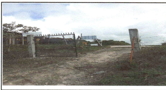
Foto 6: Instalación de portón de malla de 3.57 mts x 2.00 mts.
