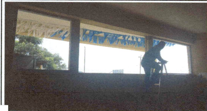
FOTO 1: Instalación de ventanas de pvc y balcones de metal con una medida de 2.32 metros por 1.23 metros
