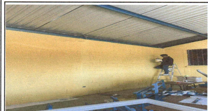
Foto 3: Distribución de Pintura en 420 mts cuadrados.
