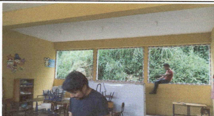
Foto 2: Instalación de ventanas de pvc y balcones de metal con una medida de 2.33 metros por 1.63 metros cada una.
