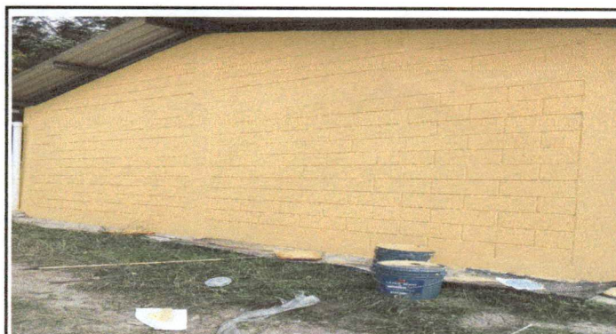
Foto 4: Distribución de Pintura en 420 mts cuadrados.
