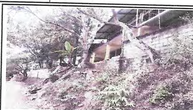
Foto 2: Reparación de muro perimetral de block con tubo y malla galvanizada, soleras intermedias y columnas
