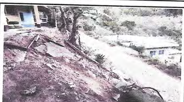
Foto 4: Reparación de muro perimetral de block con tubo y malla galvanizada, soleras intermedias y columnas
