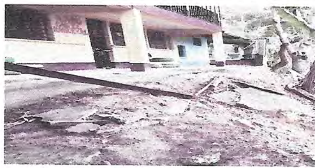
Foto 4: Reparación de piso de torta de concreto
