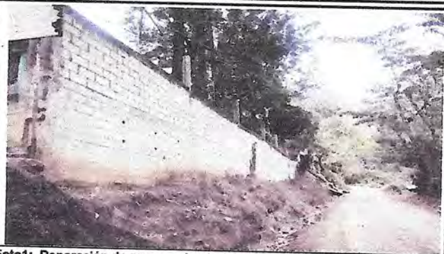
Foto 1: Reparación de muro perimetral de block con tubo y malla galvanizada, soleras intermedias y columnas
