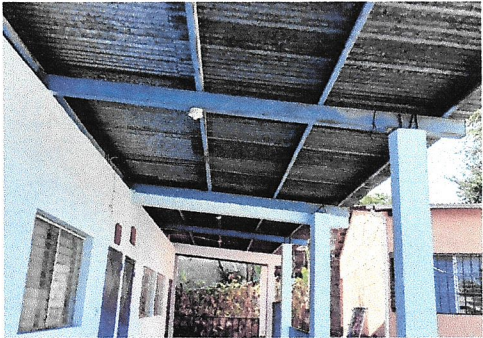
Foto1: ESTRUCTURA DE TECHO EN MAL ESTADO
