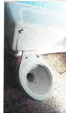
Foto 6: Sustitución de inodoros en mal estado
