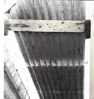
Foto 2.: Sustitución de estructura de soporte de madera, por metal
