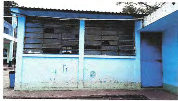
Foto 4: Sustitución de ventanas de vidrios por ventanas de pvc.
