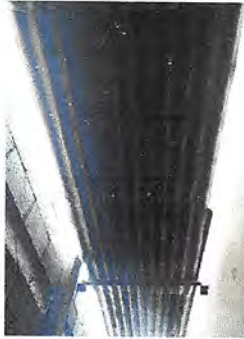
Foto1: Sustitución de lámina , por lámina troquelada calibre 26
