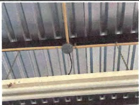
Sustitución de plafoneras
