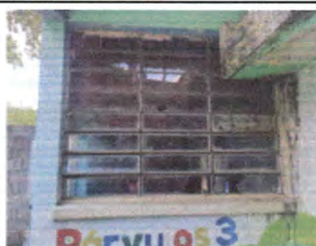
Sustitución de balcones de metal
