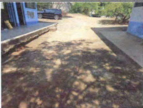
Reparación de planchas de concreto de patio
