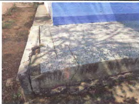
Reparación de piso de granito
