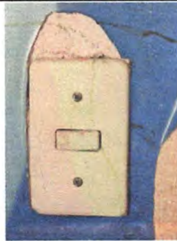
Sustitución interruptores simples
