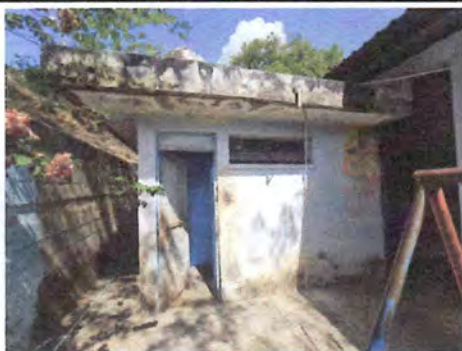
Repello en muro
