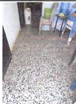
Mantenimiento de piso de granito (pulido y lustrado)
