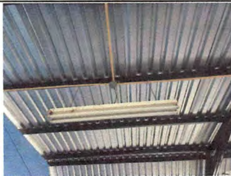
Sustitución de focos ahorradores
