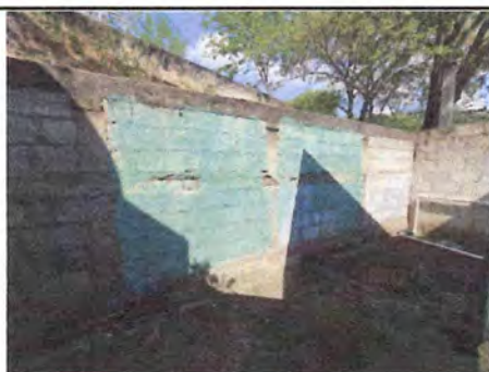
Aplicación de sabieta de muro de contención
