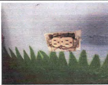
Sustitución de tomacorrientes dobles
