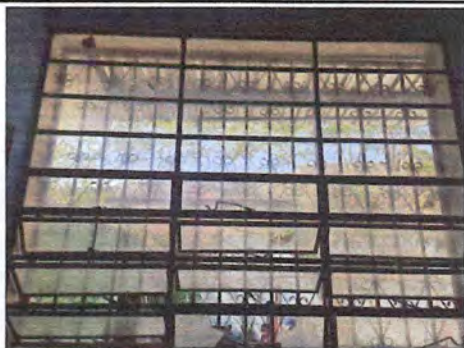
Sustitución de ventana de PVC
