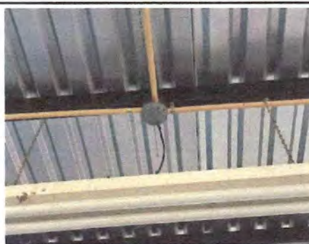
Reparación de cableado eléctrico
