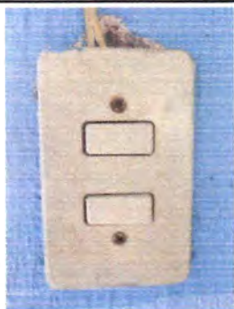
Sustitución interruptores dobles
