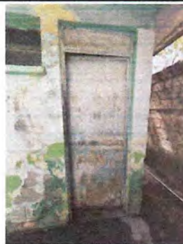
Sustitución de puerta en servicios sanitarios
