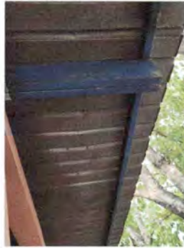
Sustitución de lámina, por lámina troquelada aluzinc calibre 26
