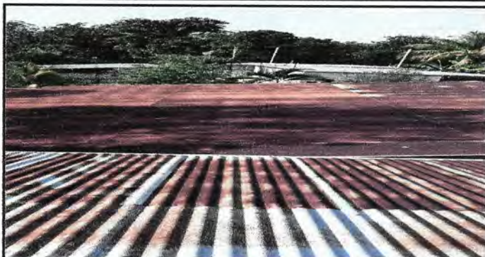
REGLON 2 ESTRUCTURA DE TECHO
