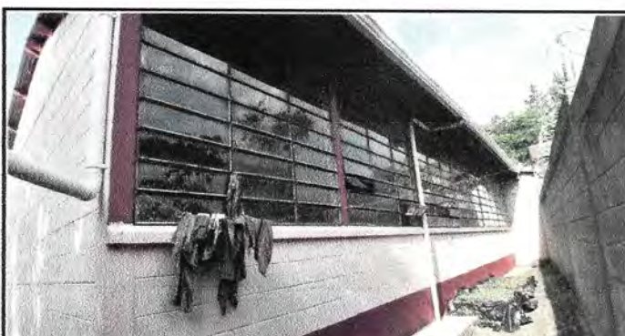
REGLON 3.1 SUSTITUCIÓN DE ESTRUCTURA DE METAL DE VENTANAS
