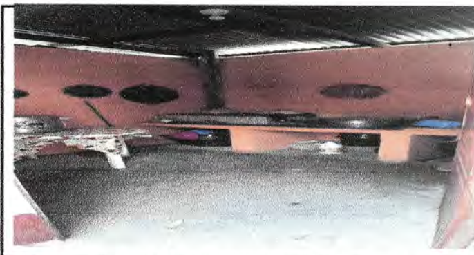
REGLON 4.1 SUSTITUCIÓN DE PLANCHA DE METAL DE 3 HORNILLAS Y REGLON 5 INSTALACIÓN DE AZULEJOS
