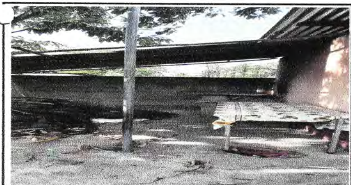
REGLON 4 REPARACIÓN DE COCINA
