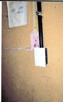
Sustitución interruptores dobles
