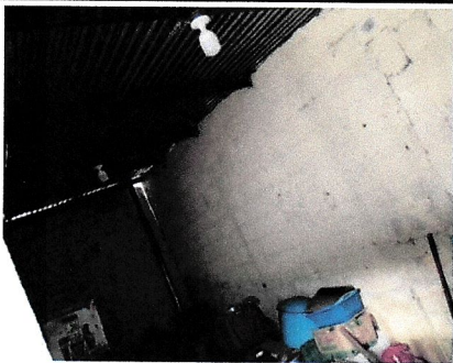
Sustitución de focos ahorradores
