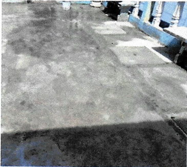
Sustitución de fosa séptica
