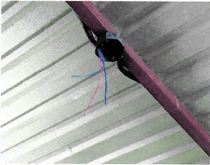
Sustitución de ducto eléctrico + accesorios
