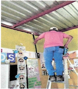
Sustitución de tablero de flipones
