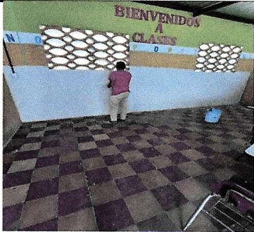
Sustitución interruptores dobles
