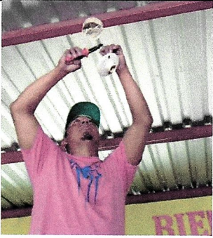
Reparación de cableado eléctrico
