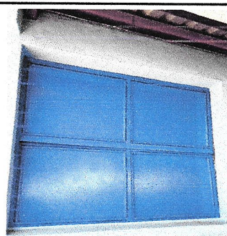
Foto 4: Mantenimiento de ventanas
