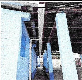
Foto 3: Sustitución de canal de pvc
