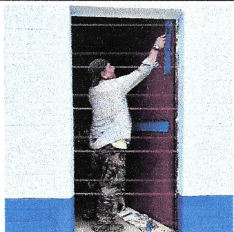
Foto 5: Mantenimiento de puertas
