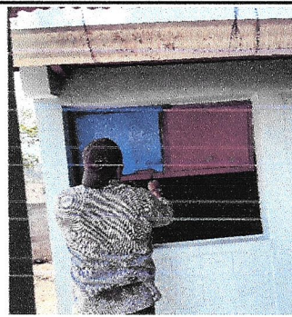
Foto 4: Mantenimiento de ventanas
