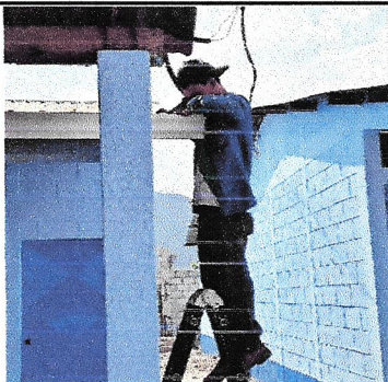
Foto 3: Sustitución de canal de pvc
