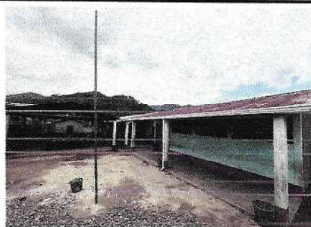
Foto 6: Pintura en muros exteriores
