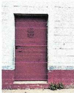
Foto 5: Mantenimiento de puertas
