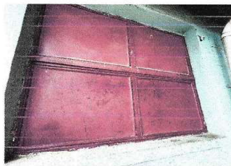
Foto 4: Mantenimiento de ventanas
