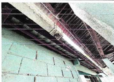
Foto 3: Sustitución de canal de pvc
