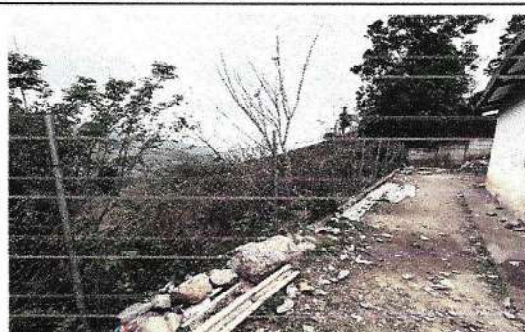
Foto 2: Seguimiento de muro perimetral de block
